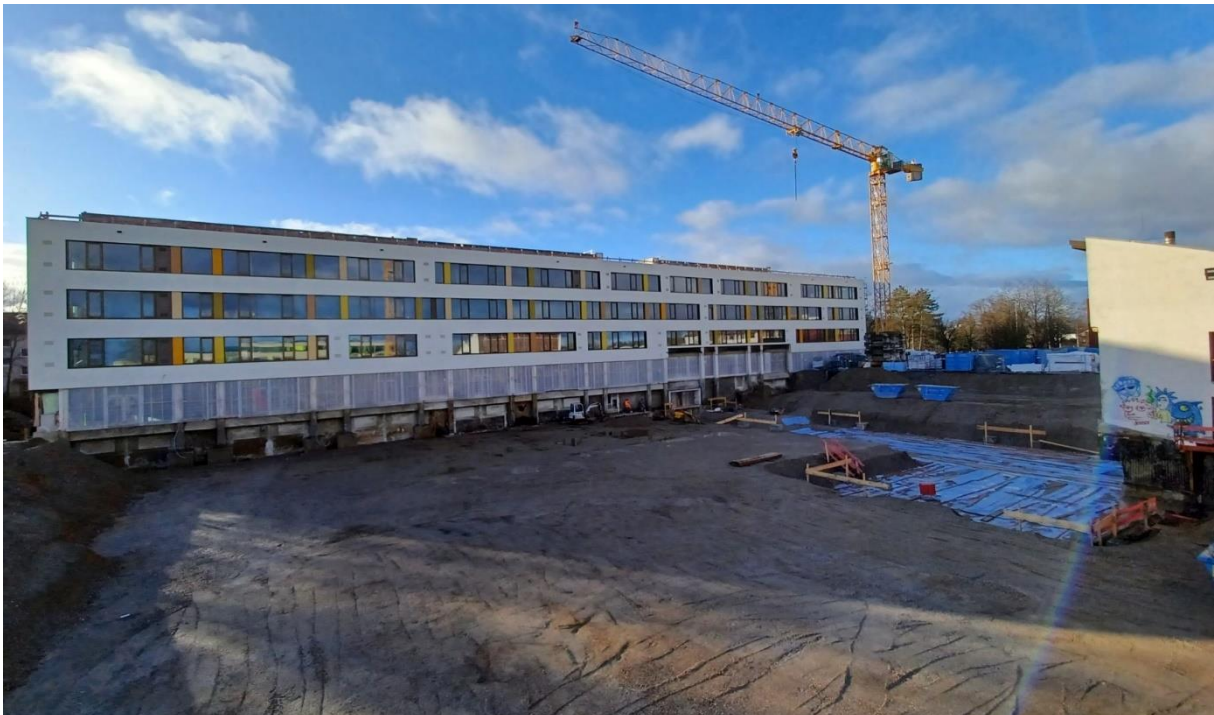
Foto Nordfassade während der Bauphase (Bildquelle: LRA Augsburg)
